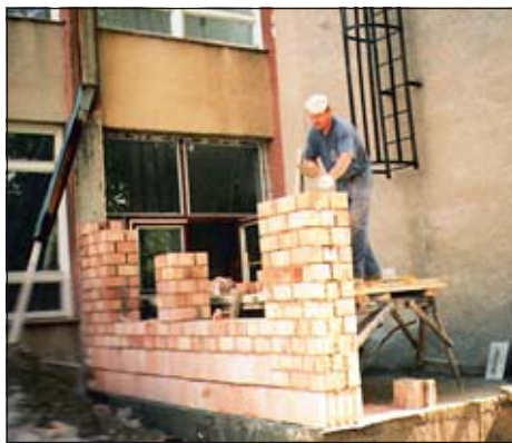
Budovanie nového vchodu
