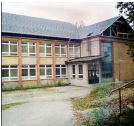
Zastrešenie budovy školy
