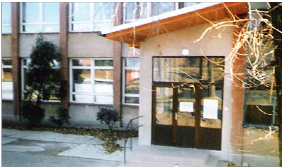
Nový vchod do budovy školy
